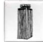
TOUR PLEYEL Avant travaux, désolé
